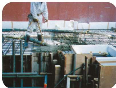
5. コンクリート打設
